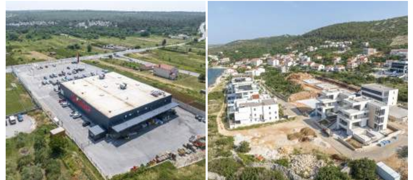
Sl. 69. Ravni krov i građevinska čestica s minimalnim udjelom zelenila trgovine Plodina (lijevo); apartmanski kompleks u izgradnji u Vinjercu (desno)
