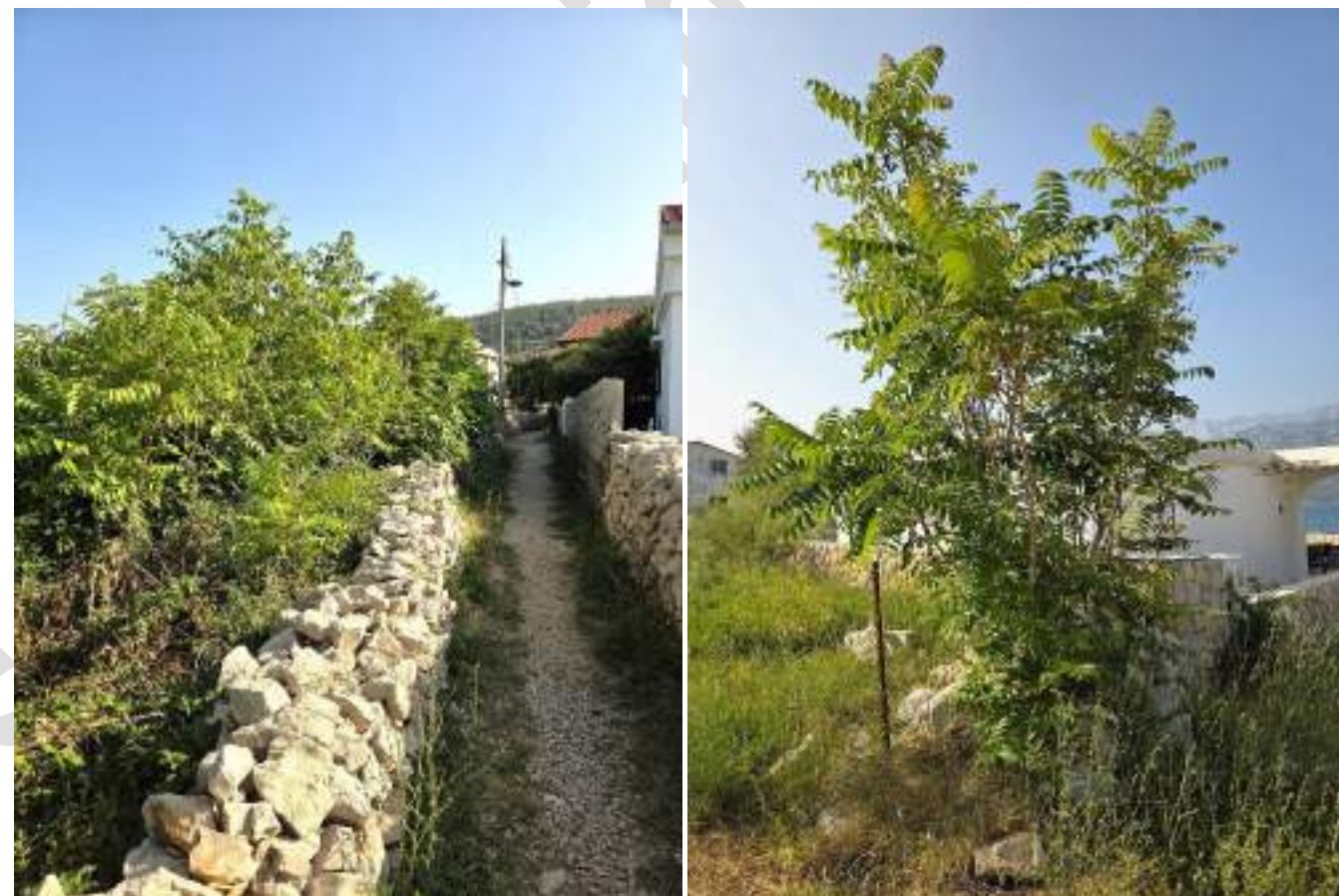
Sl. 85. Mlada stabla pajasena vrlo brzo izrastaju i dominiraju na neodržanim parcelama te oštećuju konstrukcije
