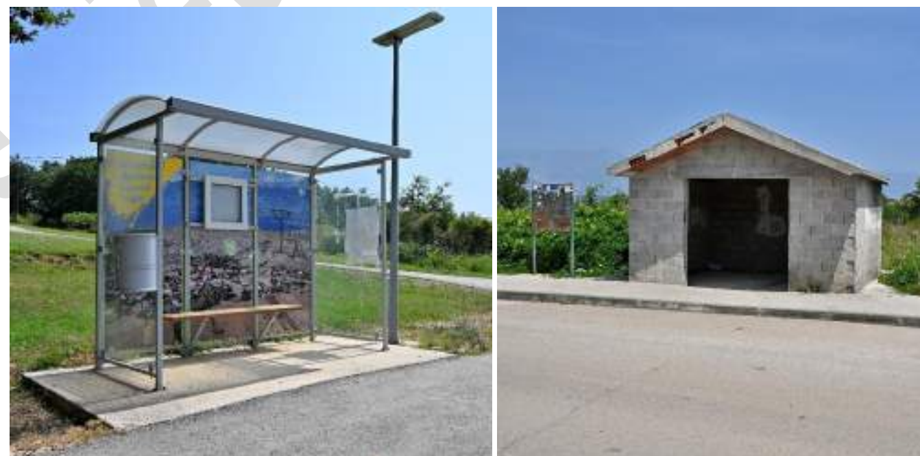
Sl. 71. Plastično-metalna nadstrešnica s klupom, kantom za otpad i rasvjetom (lijevo); zidana nadstrešnica autobusne postaje u Podgradini (desno)
