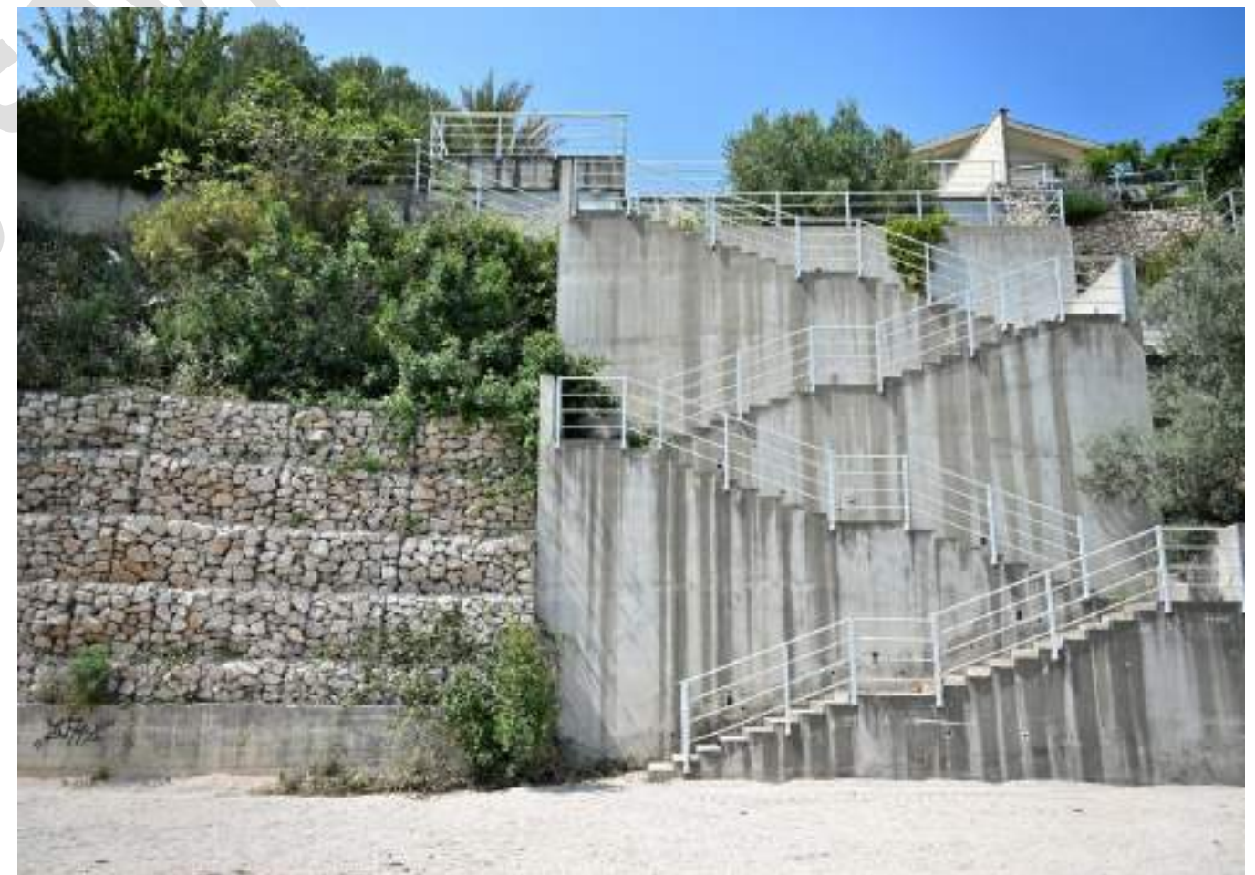
Sl. 93. Padina uz obalu u Posedarju koja je betonirana uslijed podložnosti klizanju (gore); gabionska stabilizacija padine uz betonske stepenice za pristup plaži (dolje)
