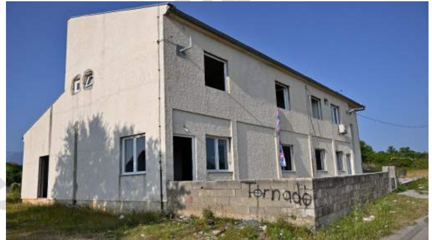
Sl. 75. Devastirana zgrada društvenog doma u Slivnici
